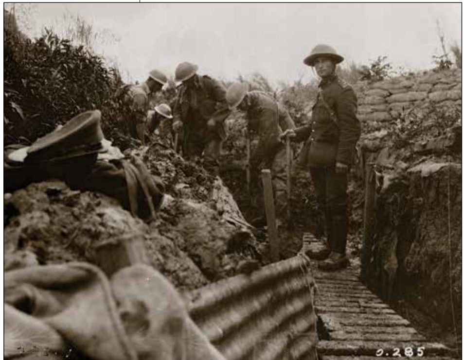
Réfection des tranchées, 22 e Bataillon, juillet 1916.
